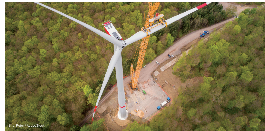
Ca. 200 Betonmischerladungen sind für das Fundament einer Windkraftanlage inkl. Kranstellfläche nötig.
